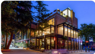
5106 开封在梁物业管理有限公司
